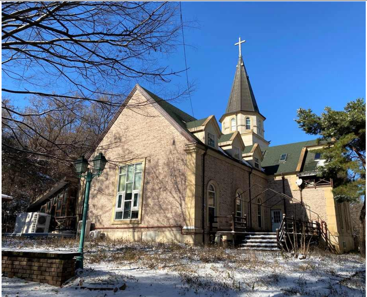
언약의 교회 전경(지붕 현황)
